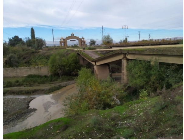
Şekil 6. Kudyalçay'daki taş ocağı (a) ve arızalanmış köprü (b).
