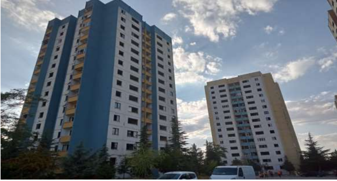
Şekil 1. Yıkımı gerçekleşen 2 blok
