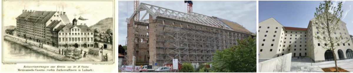
Şekil 4. Cukrarna Şeker Fabrikası İlk Hali, İnşaat Esnasındaki ve Restorasyon Sonrası Görseli (URL 14).
