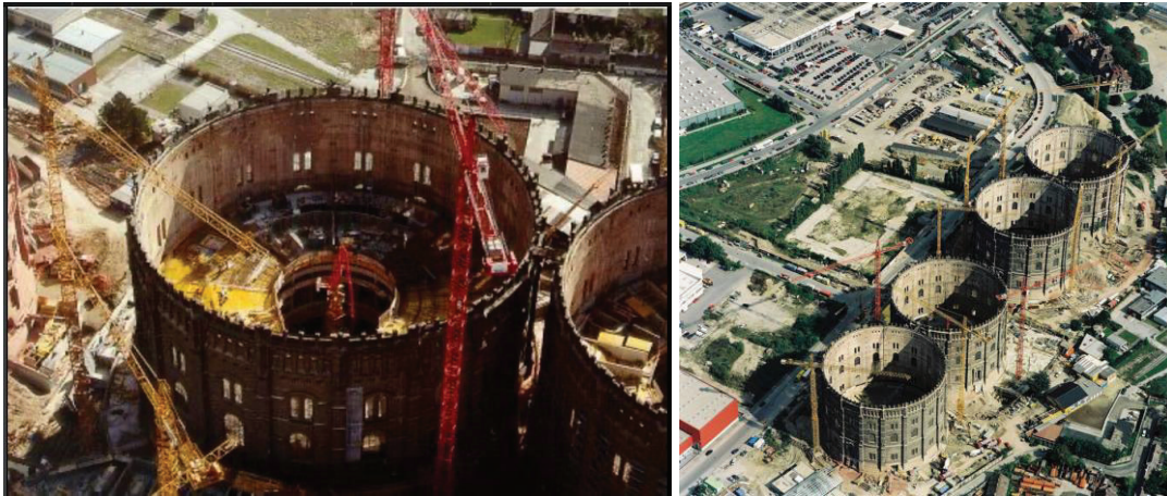
Şekil 4: Gazometrelerin yeniden işlevlendirilmesi sırasında yapım aşamaları (Url-9).
