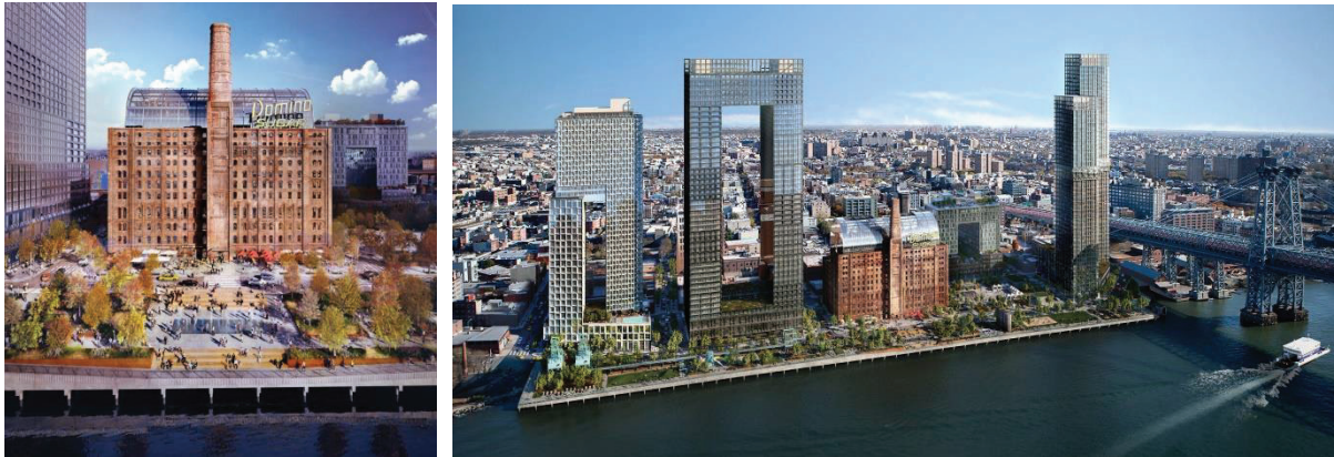
Şekil 3. Domino Şeker Fabrikası Cephe Görşelleri (URL 13).
