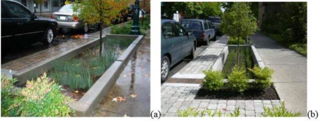
Şekil 16. (a) Yoğun yağmur yağışında bitkiler geçici olarak suyun altında kalır (b) Yağmursuz günde bitkilendirilmiş kanal ve tampon bitkilendirmesi (Sert, 2013)
