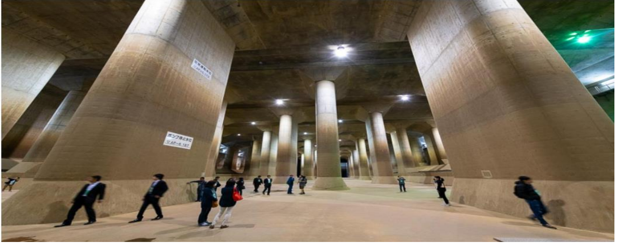
Şekil 28. Yeraltı taşkın koruma deposu
