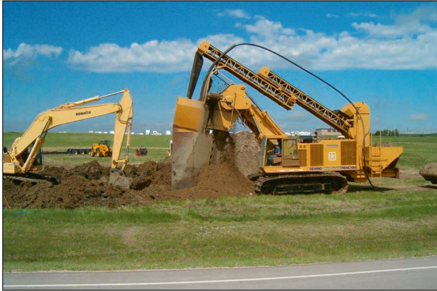
Şekil 3: Güney Dakota'daki Ellsworth Hava Kuvvetleri Üssü'nde çalışan sürekli tek geçişli hendek kazıcı (AFCEE, 2008)
