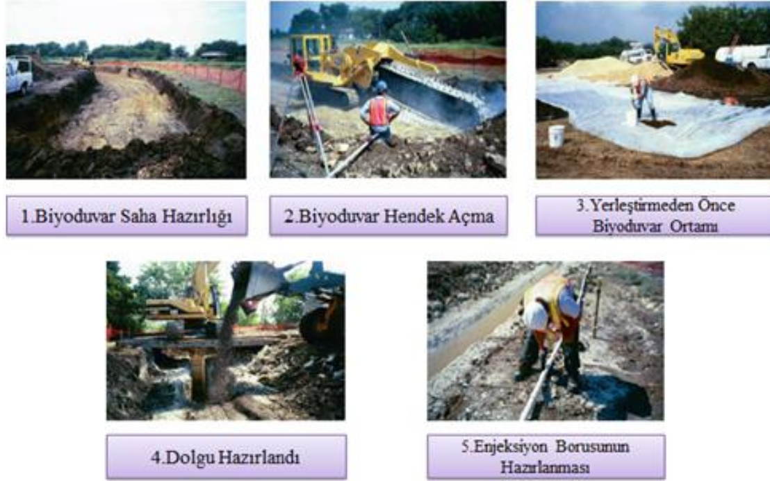
Şekil 4: NWIRP McGregor'da biyoduvar inşaatı (Fotoğraf NAVFAC Southeast'in izniyle)
