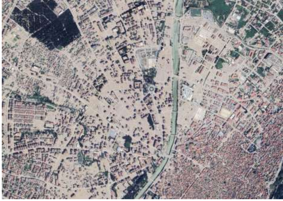
Şekil 1. Hatay/Antakya 6 Şubat 2023 depreminden sonraki görüntüsü
